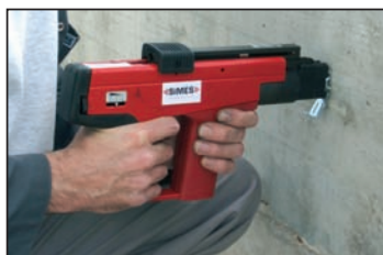
FIJACION DE COMPLEMENTOS PARA LA INSTALACION
