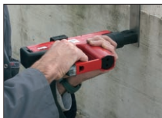
ATADO DE TABIQUES Y CLAVADO DE PLETINAS
