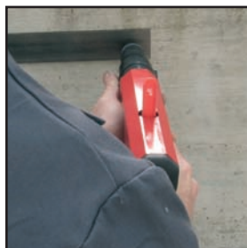
ATADO DE TABIQUES Y CLAVADO DE PLETINAS
